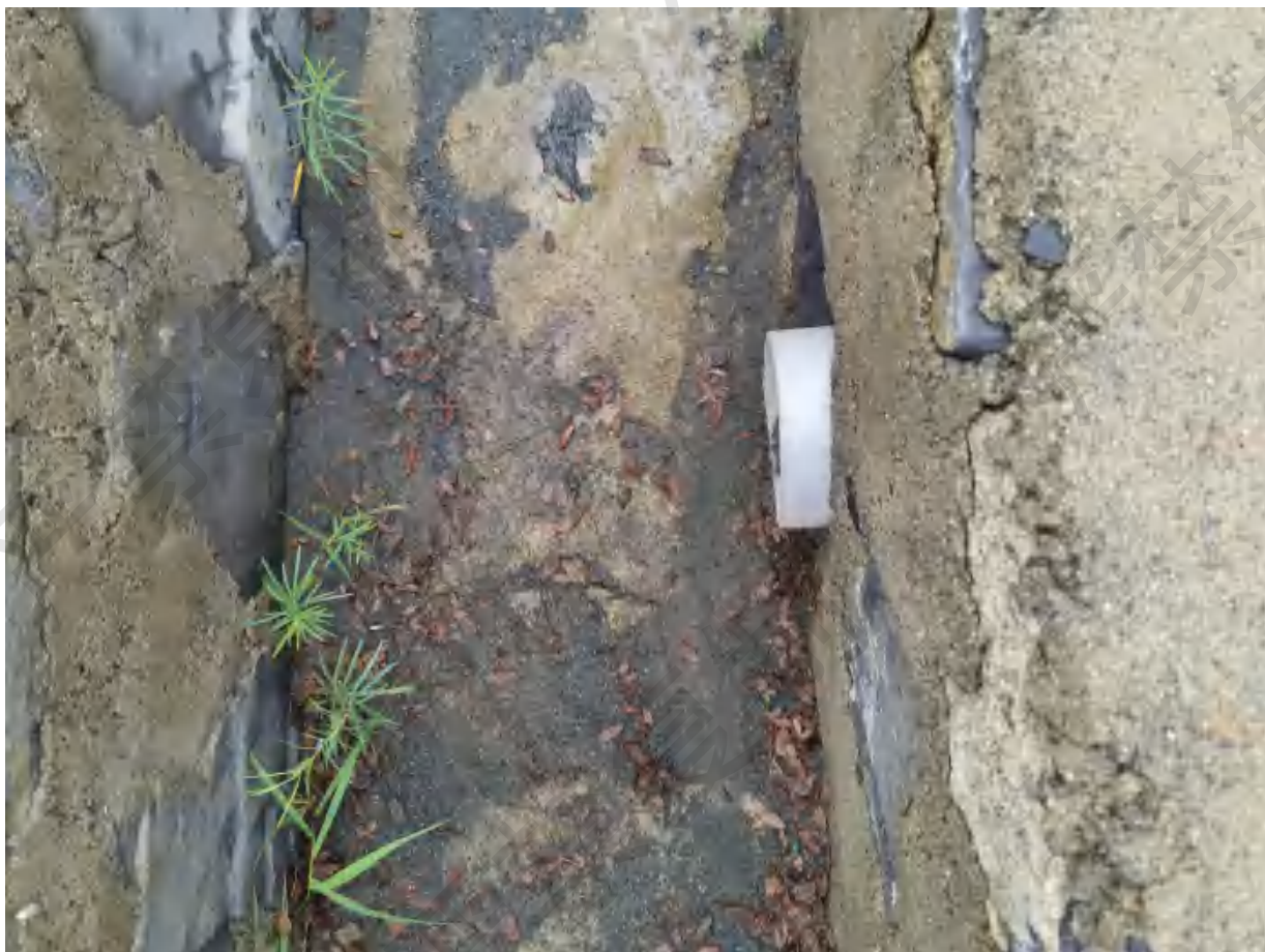
图 2.4-8 排渗导水管
