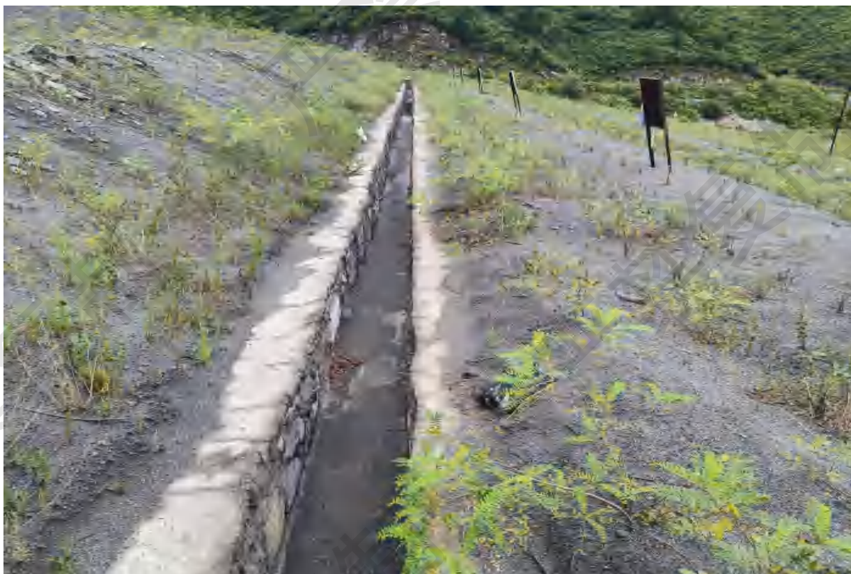
图 2.4-5 坝面纵向排水沟
