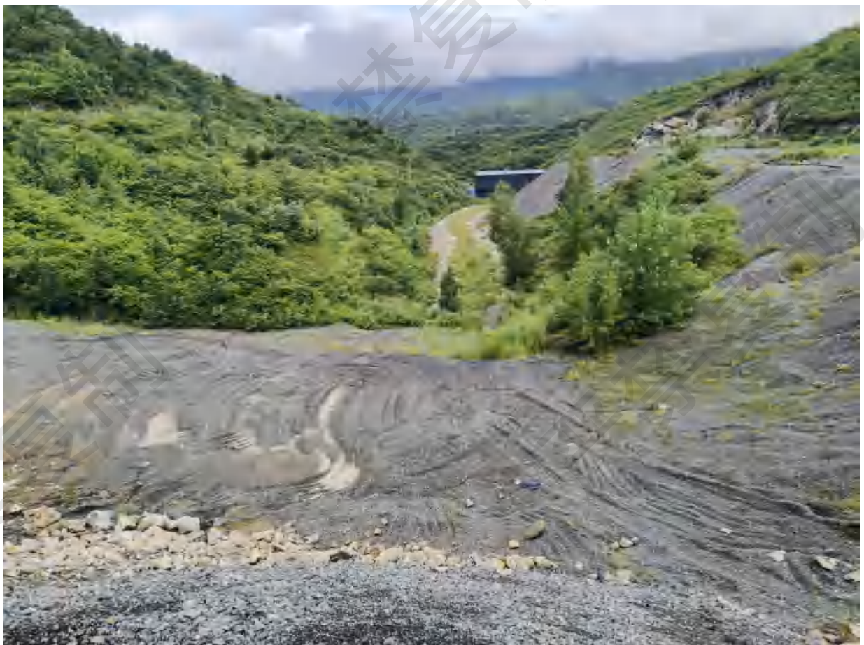
图 2.4-2 废石压坝外坡面
