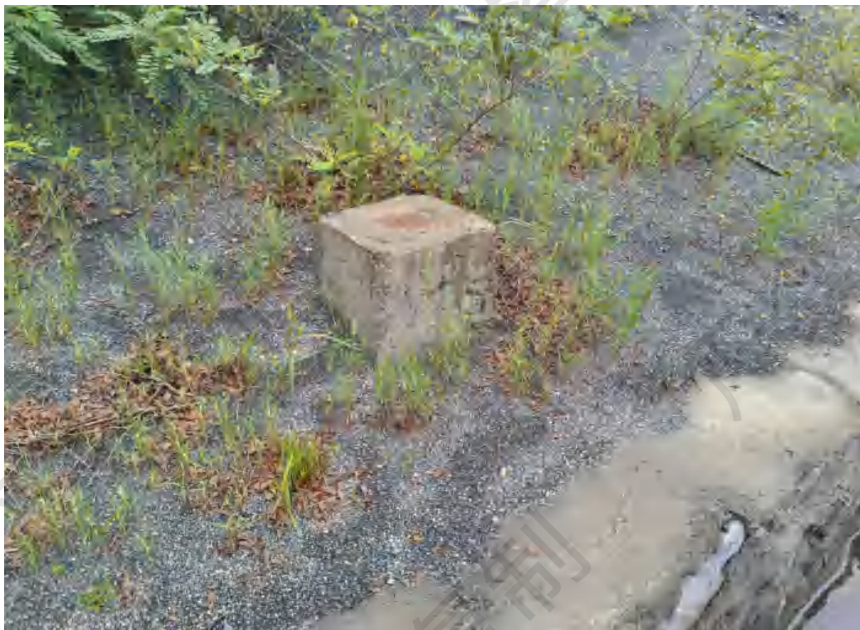
2.4-12 人工位移观测桩
