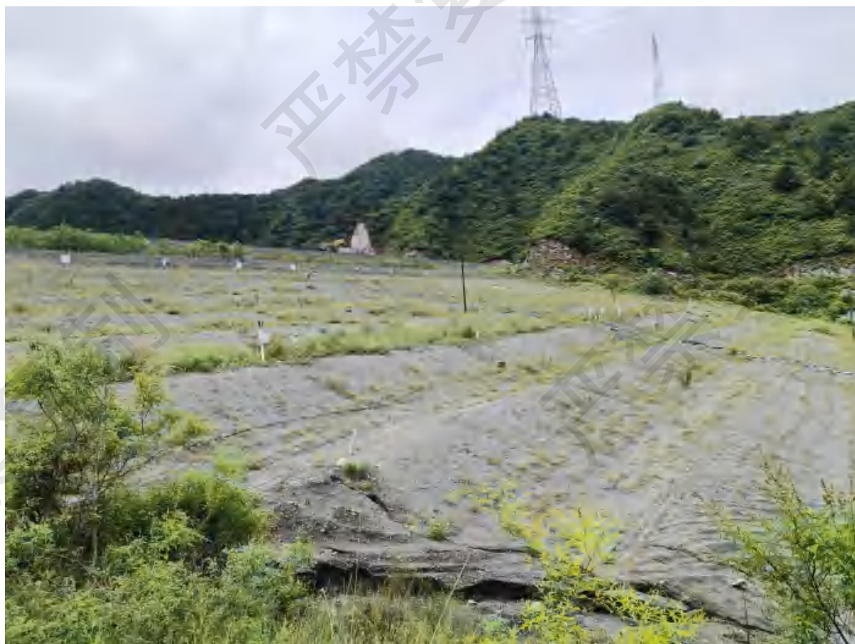
图 2.4-4 堆积坝外坡面
