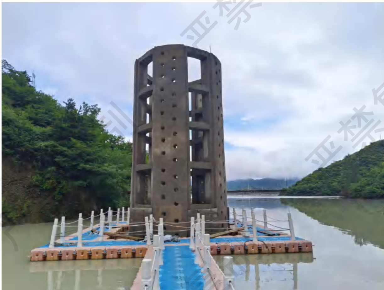
图 2.4-10 4 号排水井外观
