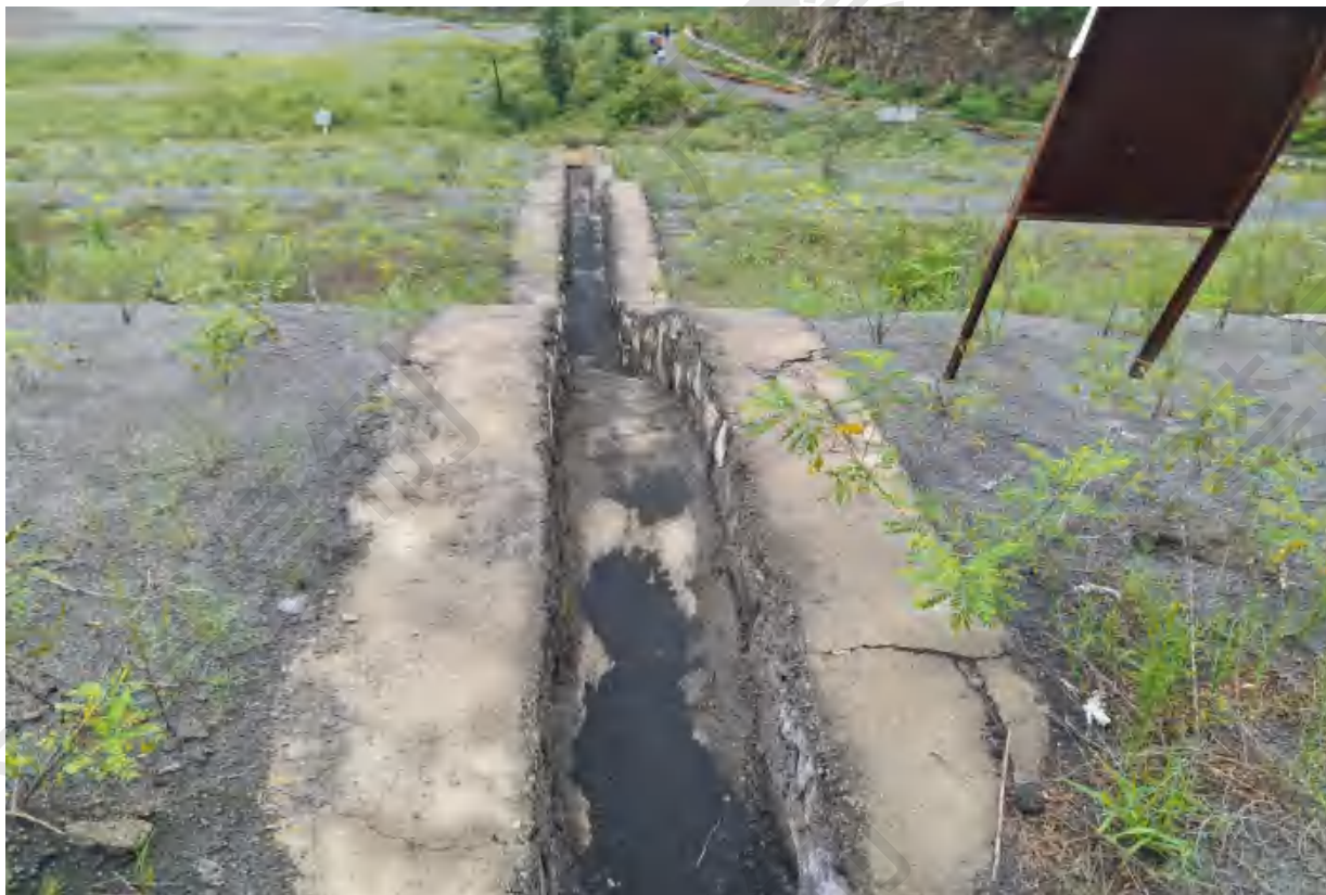
图 2.4-6 坝面竖向排水沟
