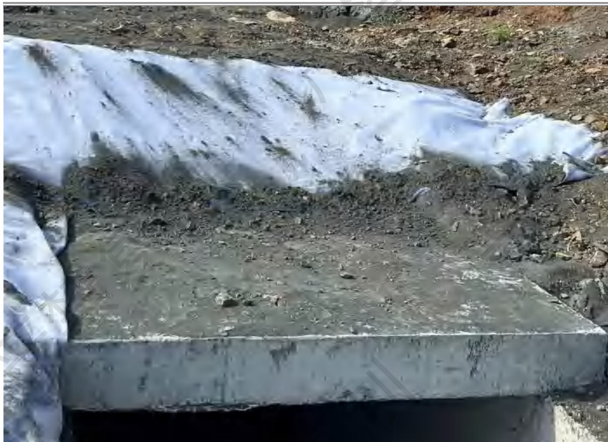
图 2.4-9.2 现浇式溢洪道
