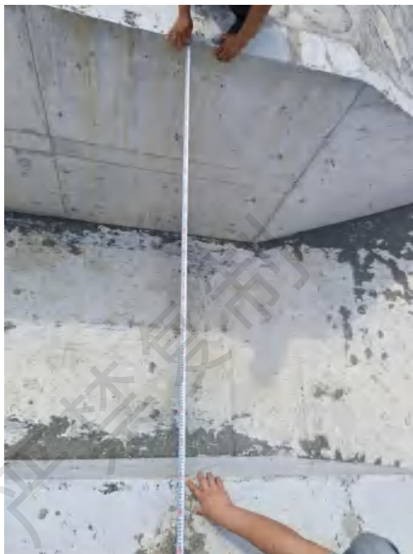
图 2.4-11 实测溢洪道宽度
