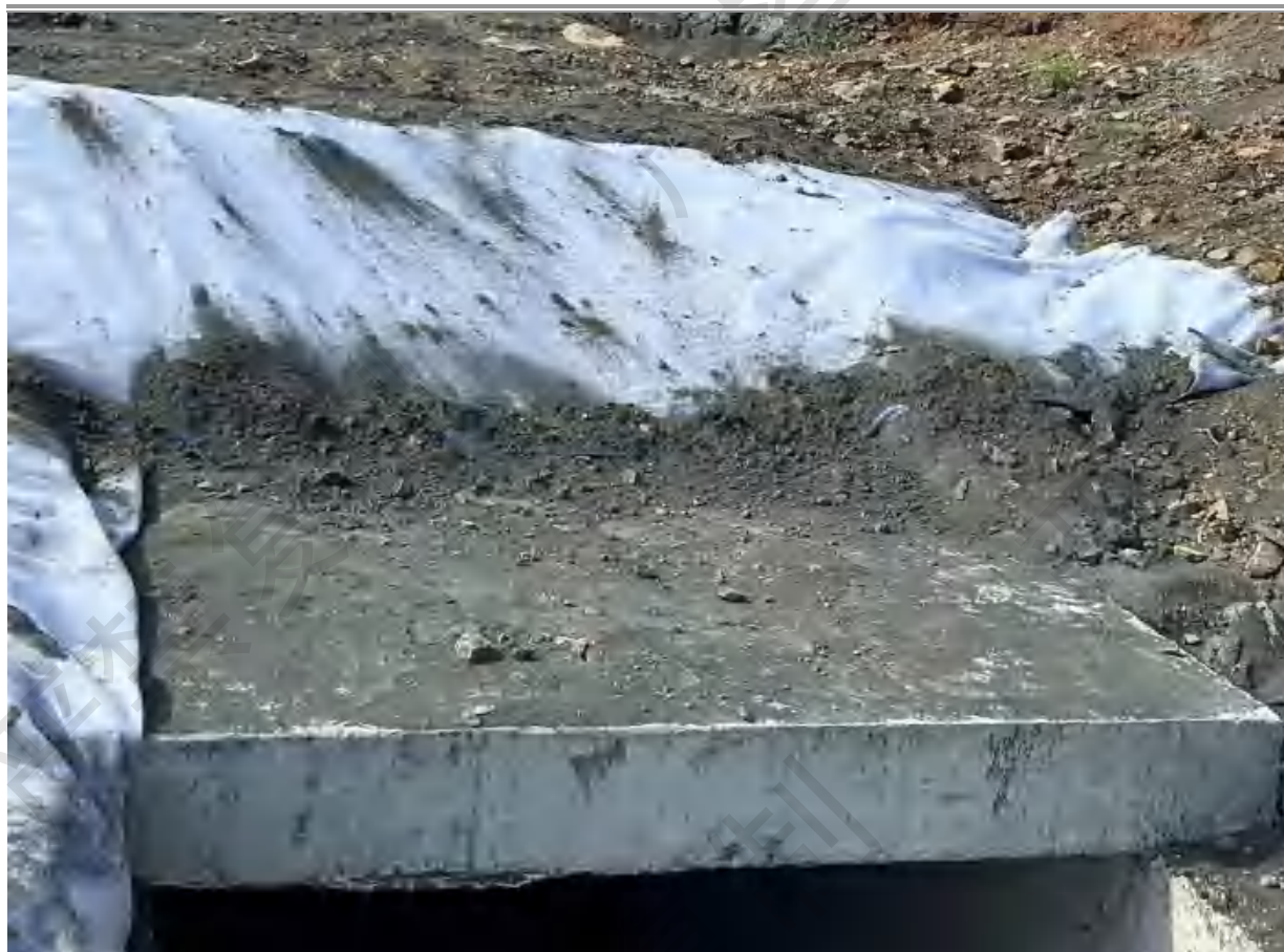
现浇式溢洪道
