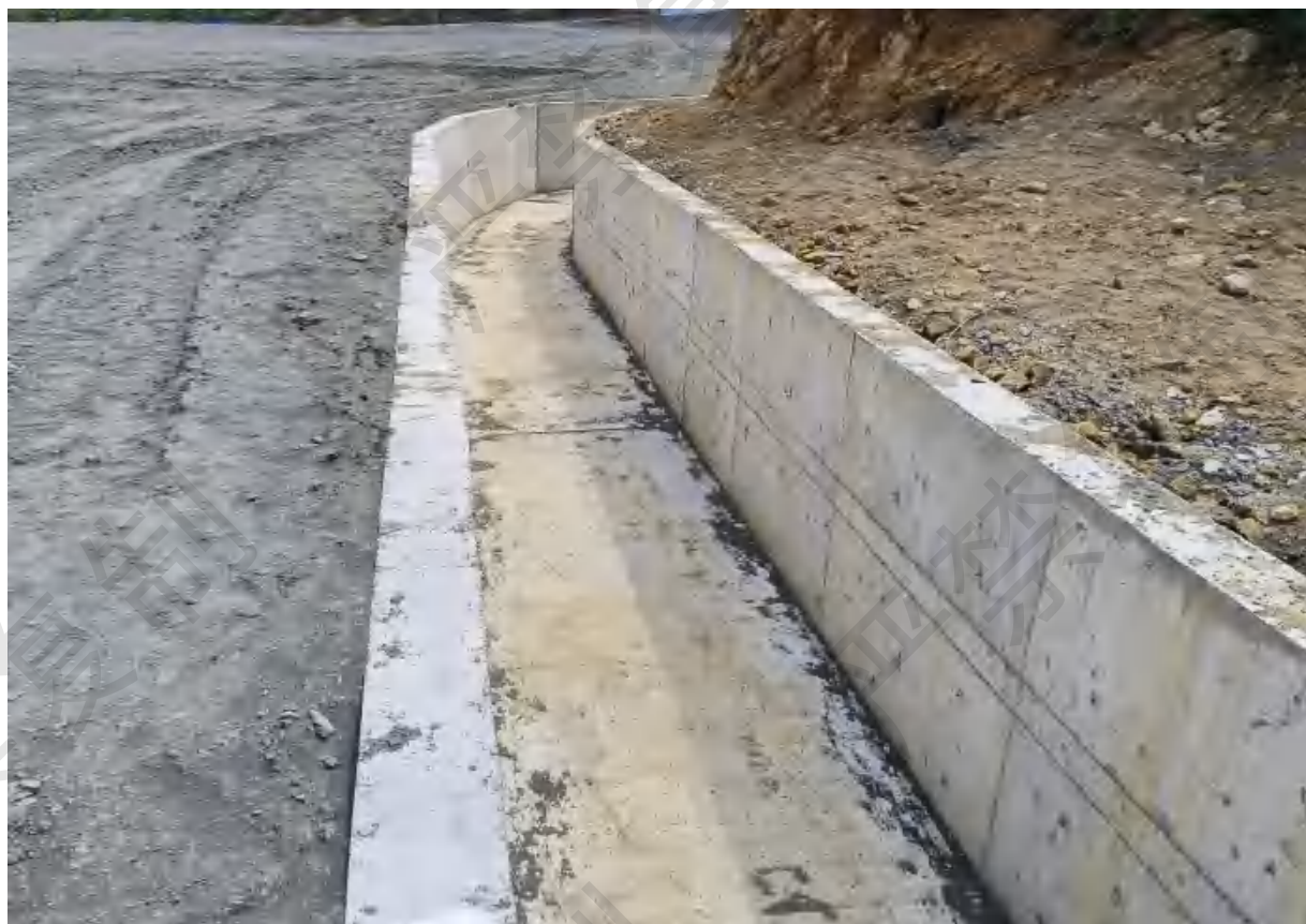
明渠式溢洪道
