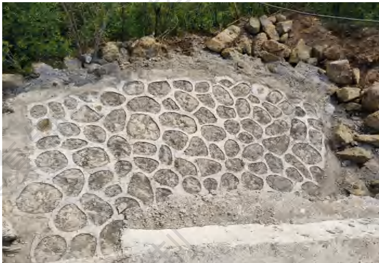
溢洪道出水口护坦
