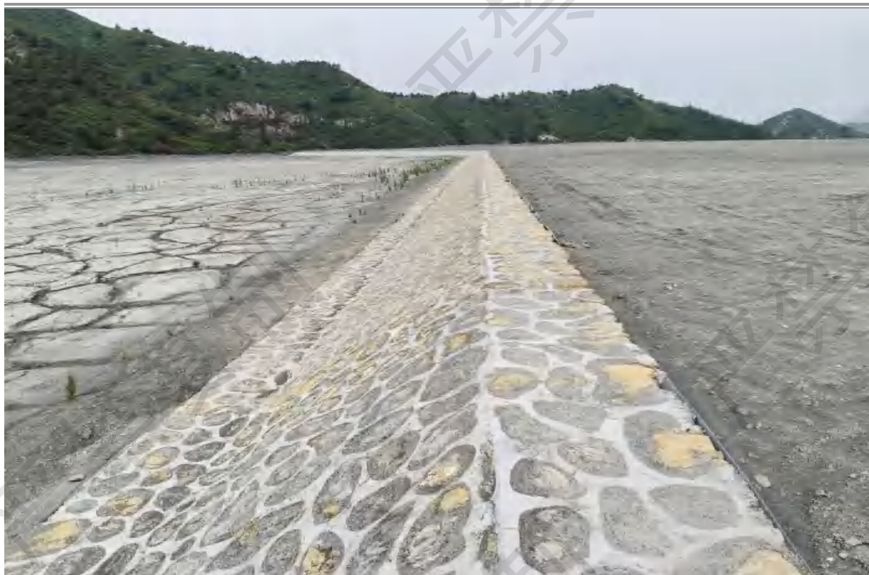
修建的防洪陡坎
