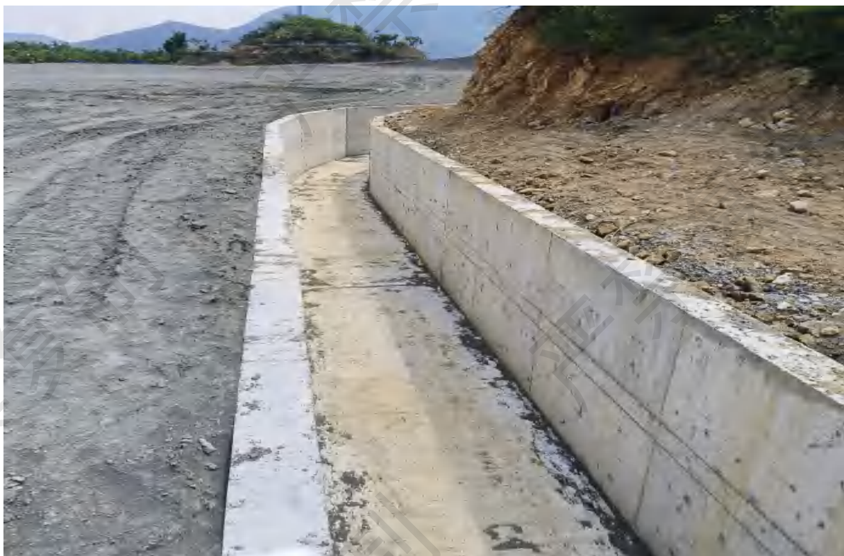
图 2.4-9.1 明渠式溢洪道
