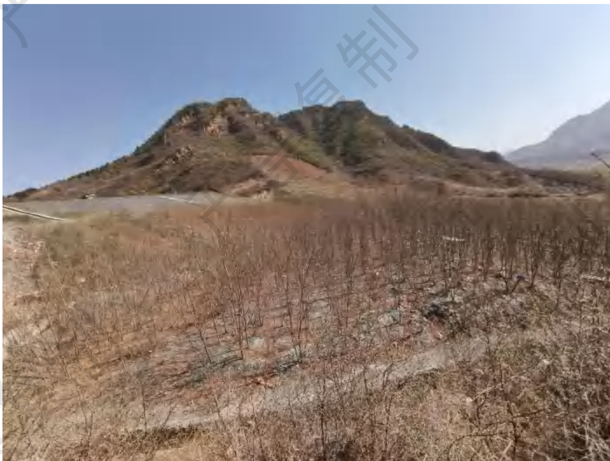
图 2.4-3 堆积坝外坡面
