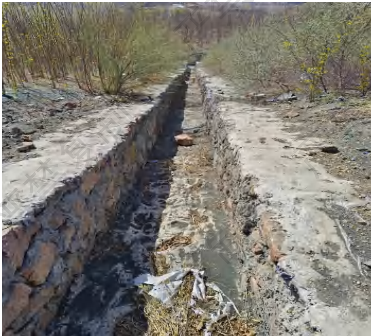
图 2.4-6 坝面竖向排水沟
