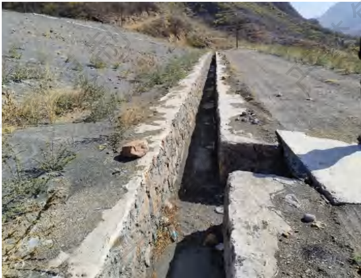
图 2.4-5 坝面纵向排水沟
