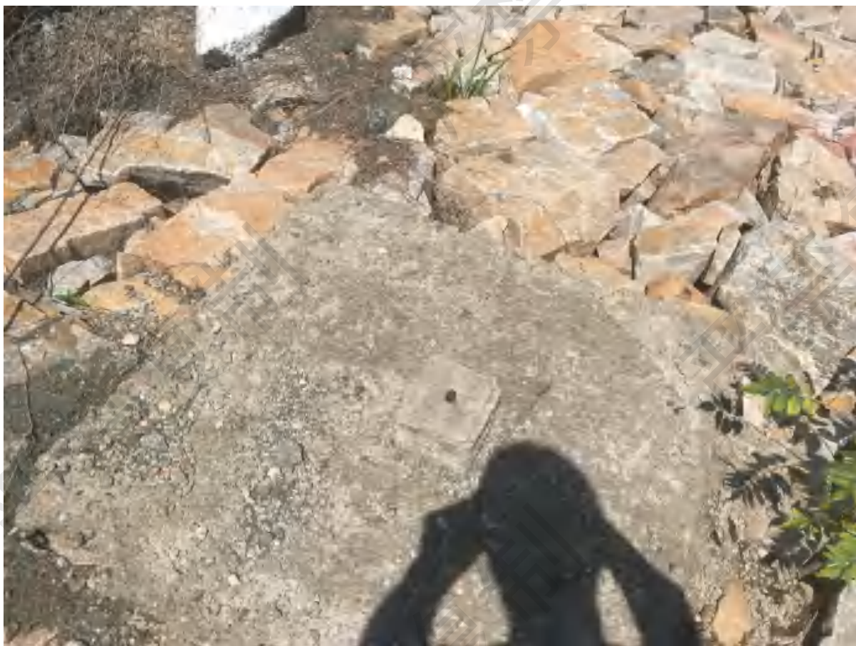
图 2.4-9 人工位移观测设施
