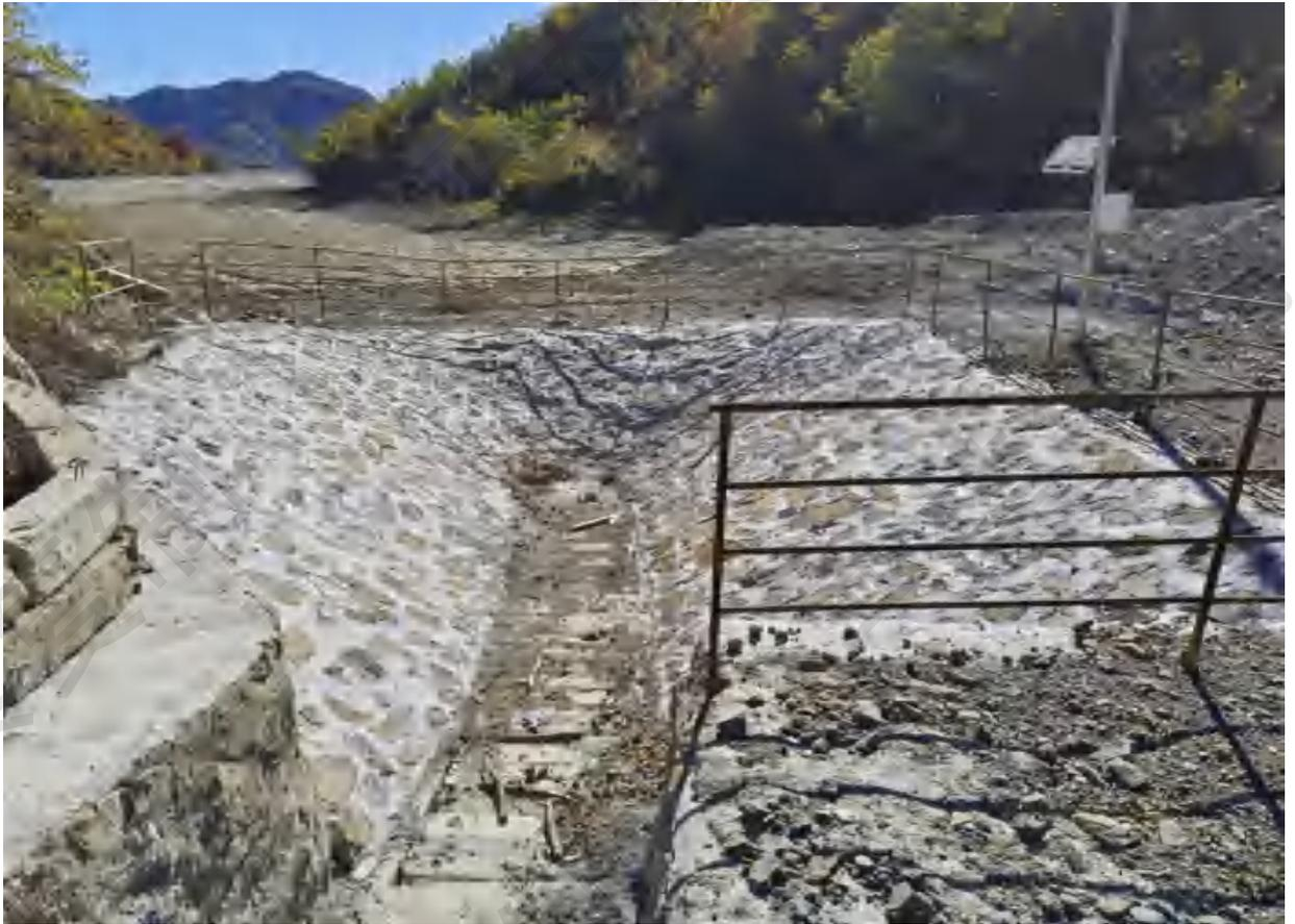
图 2.4-8 斜槽护砌及进水口处防护栏杆
