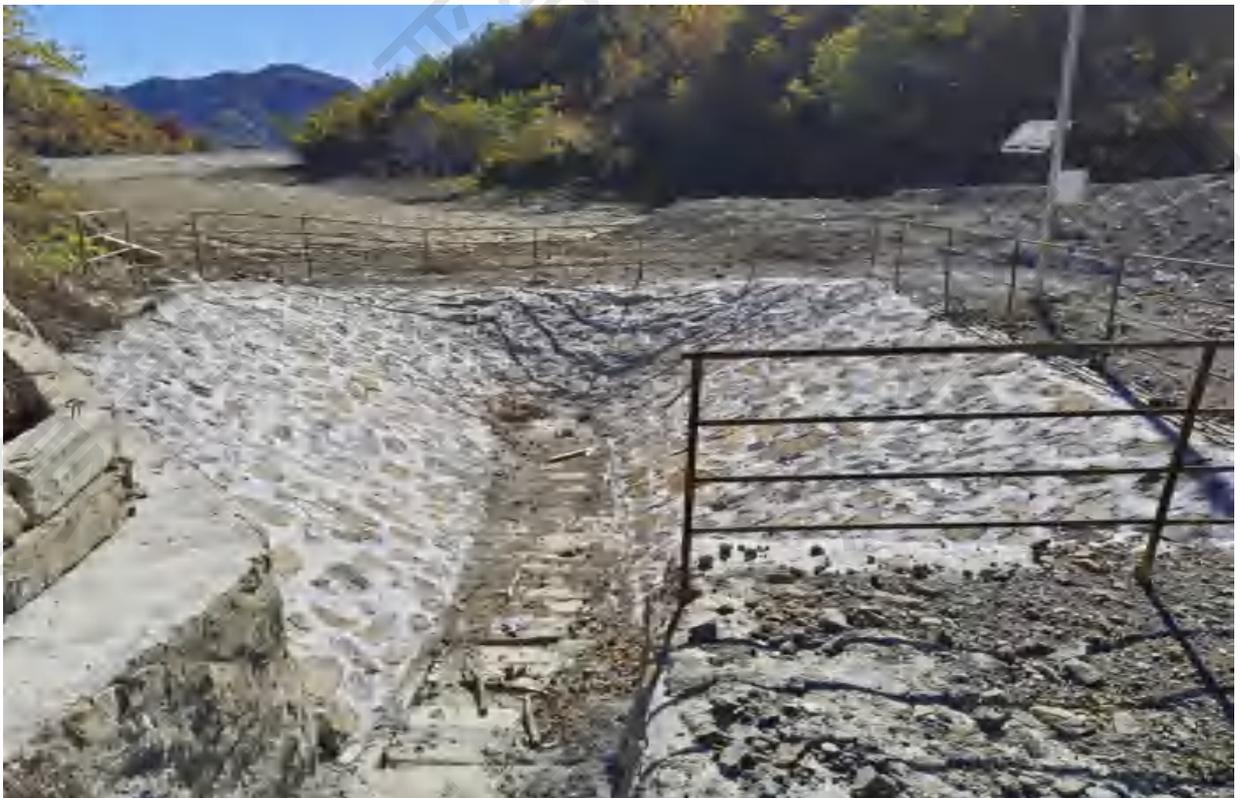
斜槽护砌及进水口处防护栏杆
