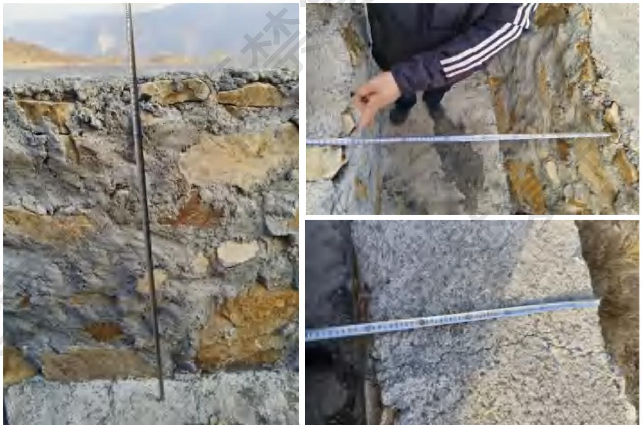
图 2.4-14 实测续接坝肩排水沟的深度、宽度及壁厚
