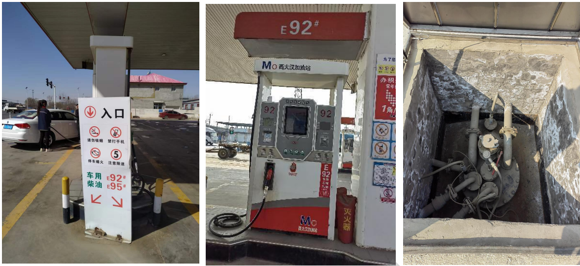
营业室紧急切断开关、配电柜、应急照明
