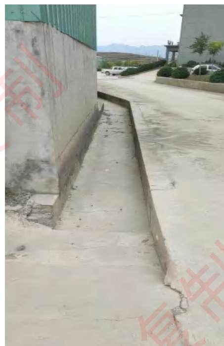
工业场地排水沟
