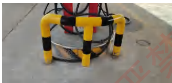
防撞栏更换为直径 100mm 的钢管
