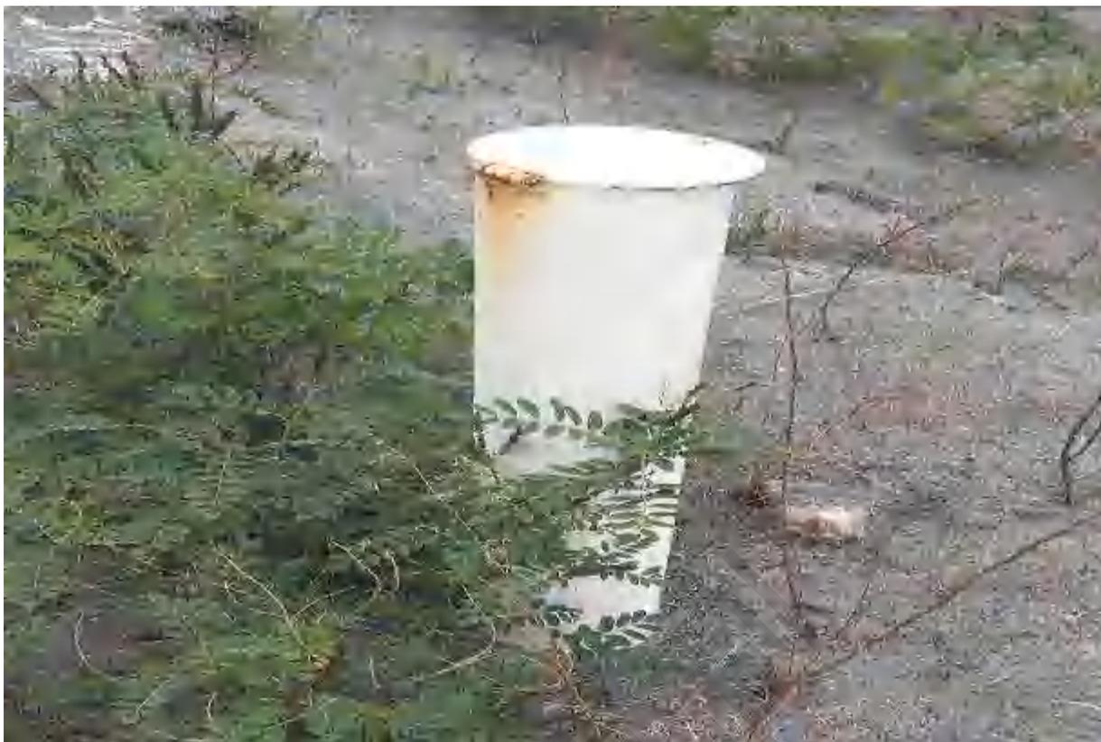
图 2.4-10 人工浸润线观测设施
